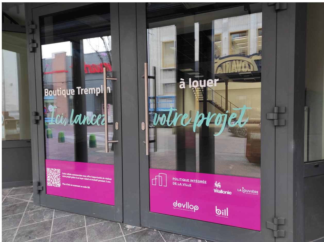
La façade du bâtiment avant la rénovation
